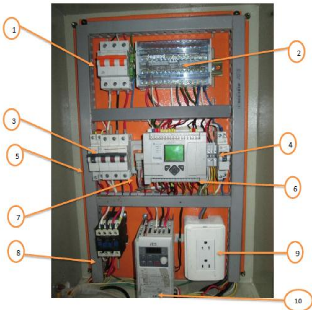
FIGURA Nº. 1 Elementos del tablero de control
