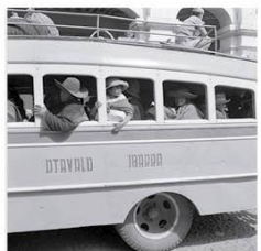
Bus Otavalo-Ibarra, a finales del año 1940. En ese entonces la estructura de la carrocería de los buses era mixta, es decir de madera y hierro.
