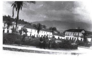
El Parque Bolívar captado desde la calle Sucre en 1920.
