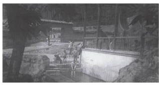
El baño largo estaba ubicado en la fuente del Secajón, al fondo podemos observar la fábrica de tubos que se encontraba más arriba de la piscina Neptuno. Fotografía de 1930.
