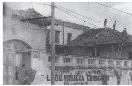
En la Calle Juan de Dios Morales, funcionaba la fábrica de sodas y cerveza artesanal, que abastecía a la ciudad de Otavalo.
