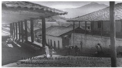
EL EMPEDRADO El tradicional barrio el empedrado, Fotografía del año de 1941.
