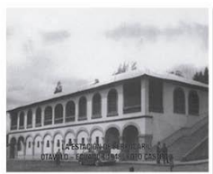
En la fotografía podemos observar la Estación de Ferrocarril en la ciudad de Otavalo en el año 1948.
