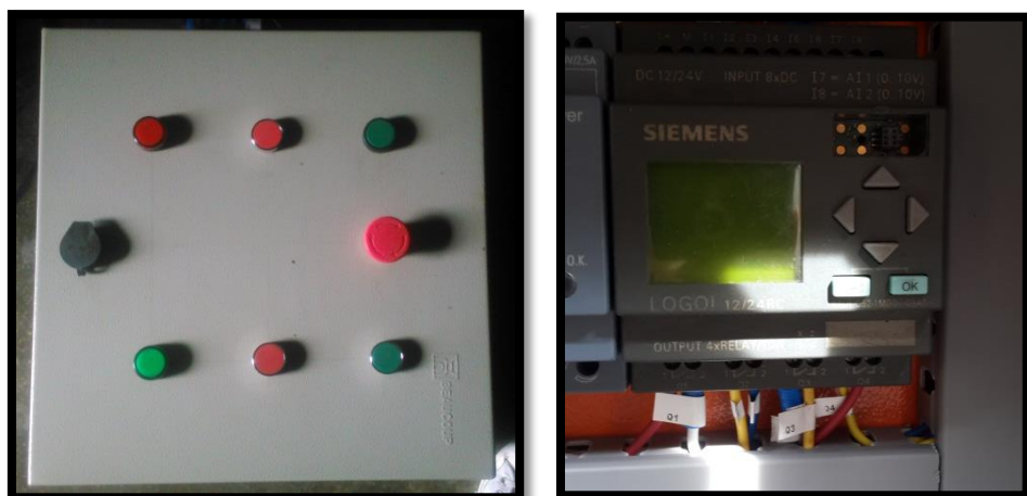
FIGURA 3.70 Colocación de luces y pulsadores
