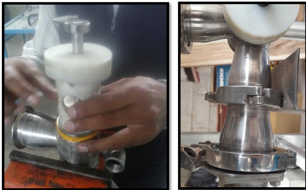
FIGURA 3.58 Construcción de sistema de dosificación
