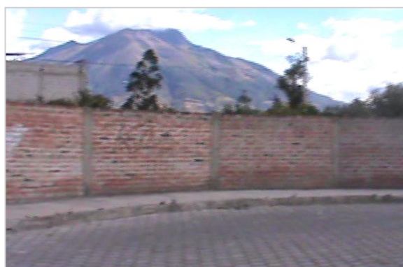
Figura 6. Obra complementaria cerramiento.
