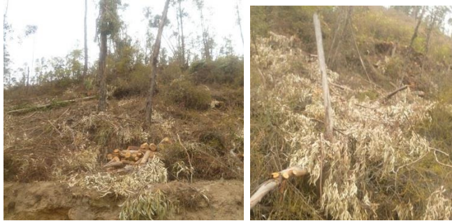
Figura 5.19. Corte del eucalipto para limpieza del canal de riego
