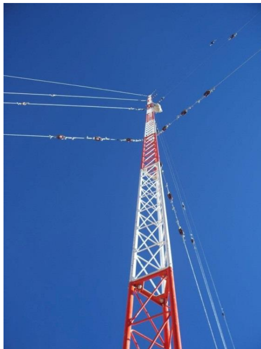
Figura 116. Torre soportada por tirantes
