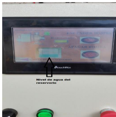
Figura 7: Nivel de agua en el reservorio
