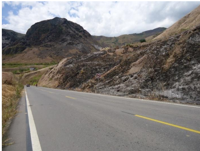
Foto 4. Área afectada Carolina
