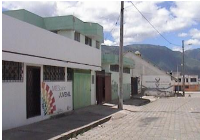
Fuente: Autor, parte frontal de la casa comunal y sala de velaciones año 2.014 Elaborado por: El Autor
