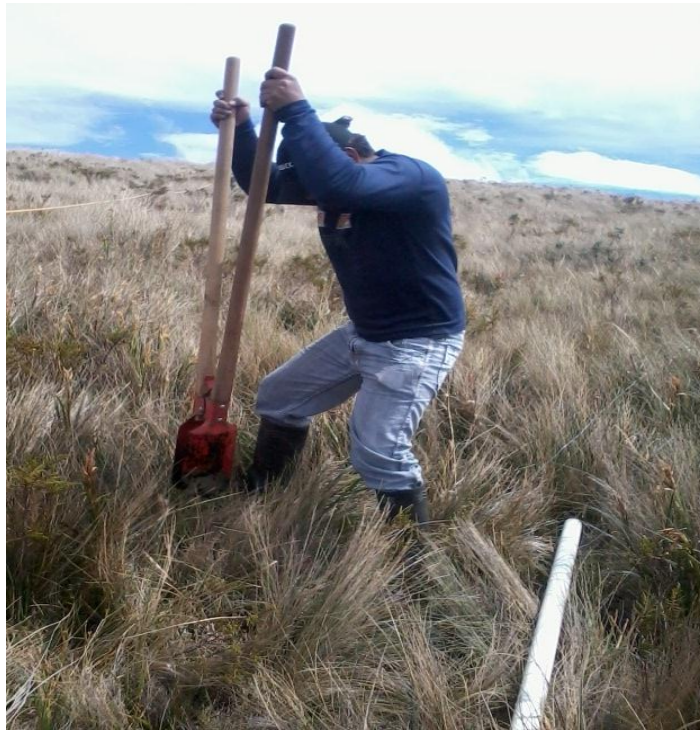
Fotografía 3. Hoyado para la ubicación de los tubos PVC
