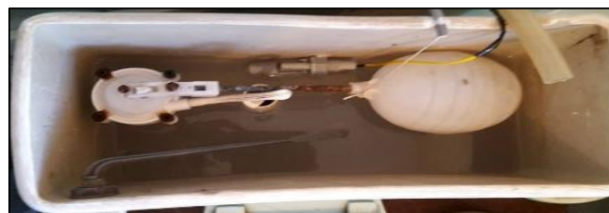
Figura 47. Conexión de la manguera con el tanque del inodoro Fuente: Autoría
