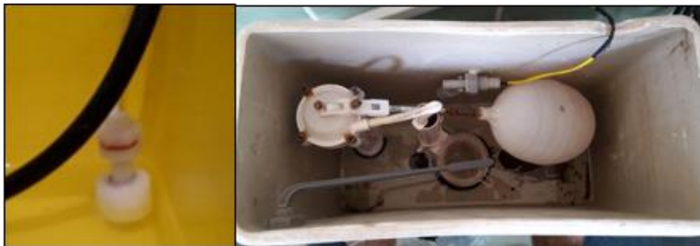
Figura 45. Ubicación de los sensores de nivel de agua Fuente: Autoría
