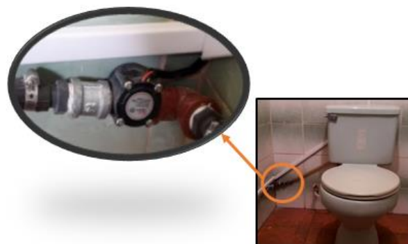
Figura 19. Instalación del sensor de flujo de agua Fuente: Autoría
