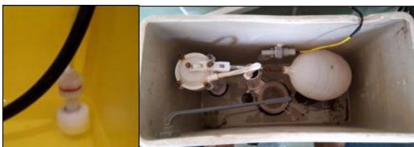
Figura 21. Ubicación de los sensores de nivel de agua Fuente: Autoría
