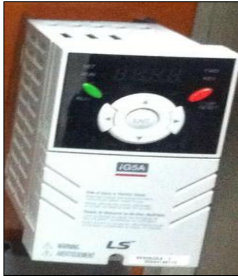
FIGURA 4. 5: Variador de velocidad
