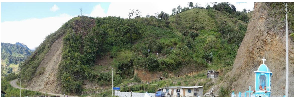
P34 Deslizamiento en la vía
