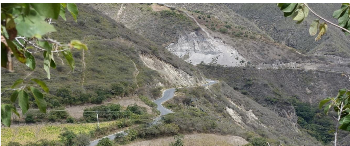
P21 Deslizamiento en la vía a Cahuasquí
