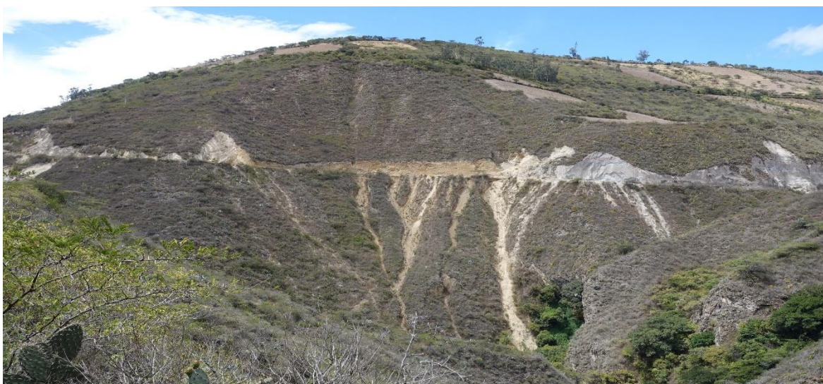
P26 Deslizamientos en la vía
