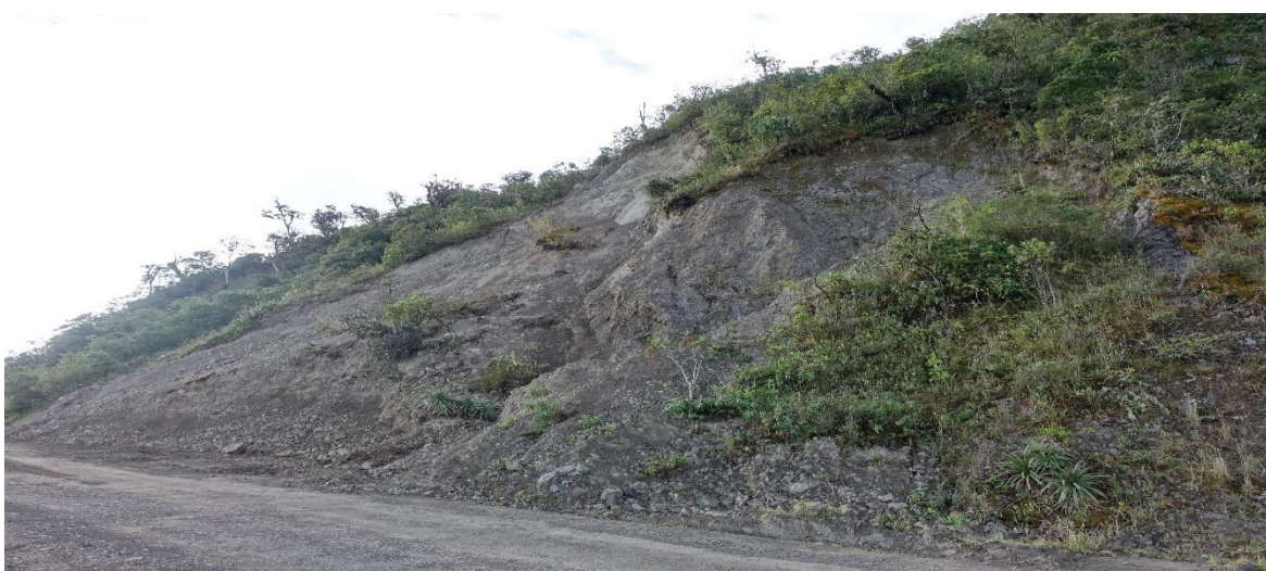
P38 Deslizamiento en la vía
