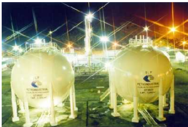
Figura 1.7. Instalaciones del Complejo Industrial Shushufindi
