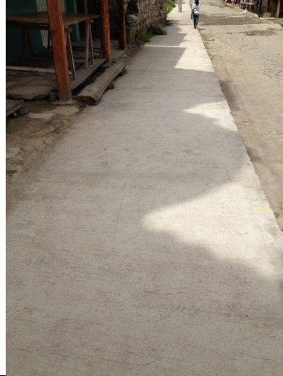
AF 7.- Acera paralela a camino empedrado
