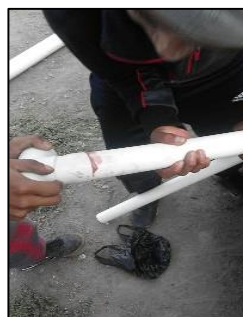
Figura 103. Colocando los codos en cada parte de los tubos pvc Fuente: Este estudio, 2016
