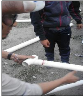
Figura 104. Empatando los tubos PVC Fuente: Este estudio, 2016
