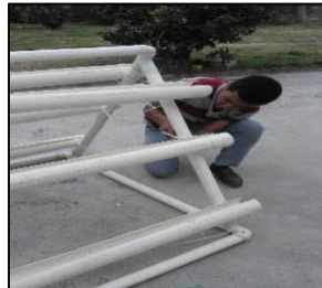
Figura 105. Armando la base con los tubos PVC Fuente: Este estudio, 2016
