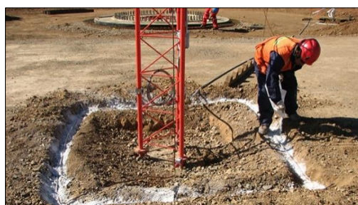
Figura 96: Instalación de un sistema de puesta a tierra para torres de telecomunicaciones
