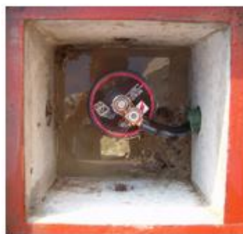
Figura 85. Punto de registro - borne del electrodo
