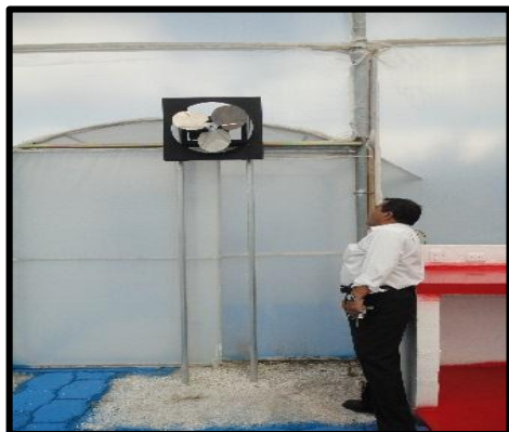
Foto N° 7 Instalación de ventiladores
