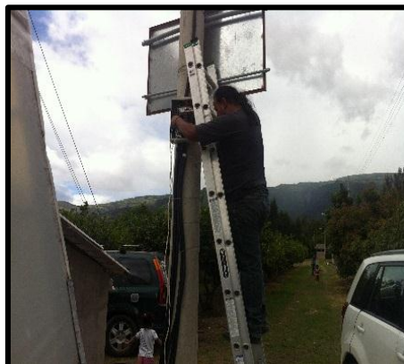
Foto N° 8 Instalación de generador
