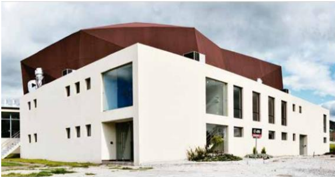
Figura 20 Instalación (Fábrica Imbabura)
