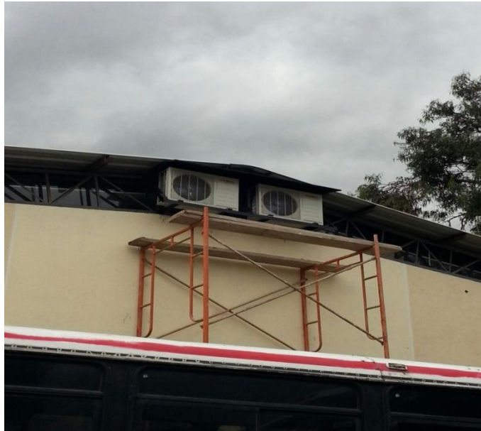
Figura 28: Unidad exterior colocada. Fuente. Foto tomada por el investigador (2015).
