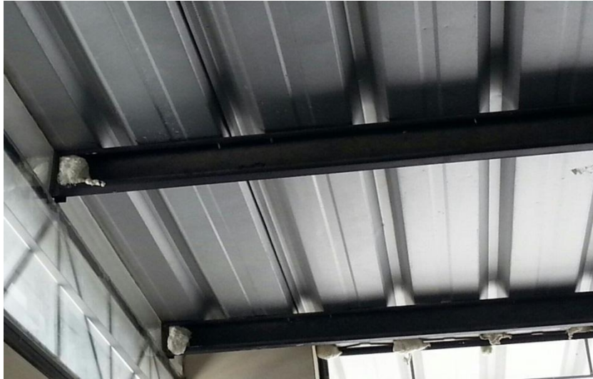
Figura 26: Techo con aislamiento de entradas de aire. Fuente. Foto tomada por el investigador (2015).
