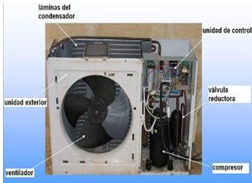
Figura 21: Partes de la unidad exterior Fuente. Instalaciones eléctricas Román (2013).
