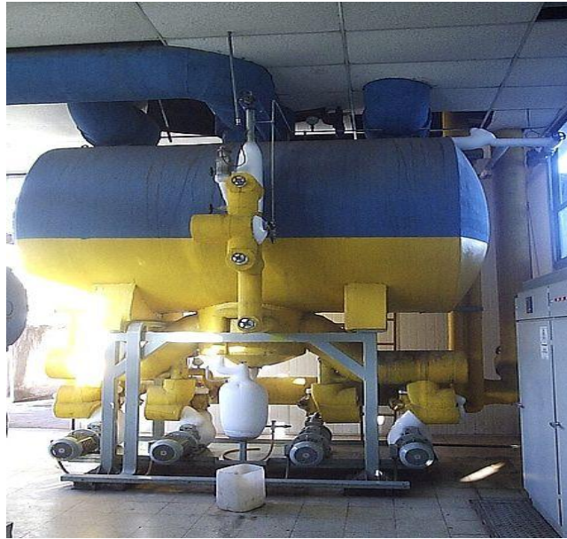
Figura 7: Estanque de recirculado de Amoniaco. Fuente. Neurotonix (2010).
