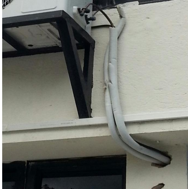
Figura 32: Cañerías colocadas Fuente. Foto tomada por el investigador (2015).
