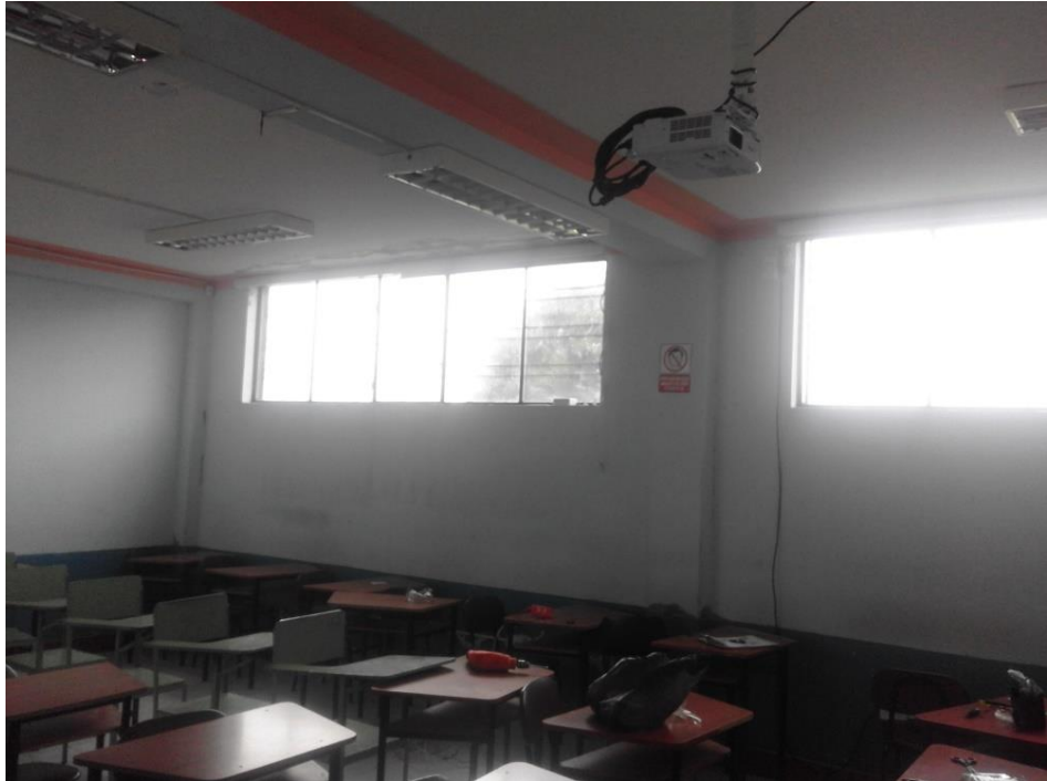
FIGURA 68: Instalación de las persianas.
