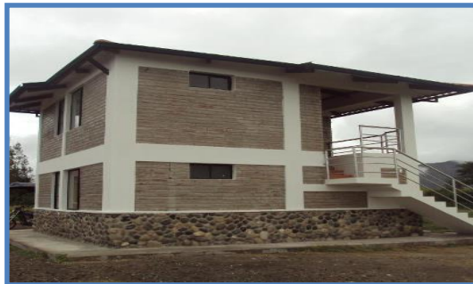
Fotografía No. 14: Hospederías Comunitarias Fuente: Anderson Maldonado. 2014
