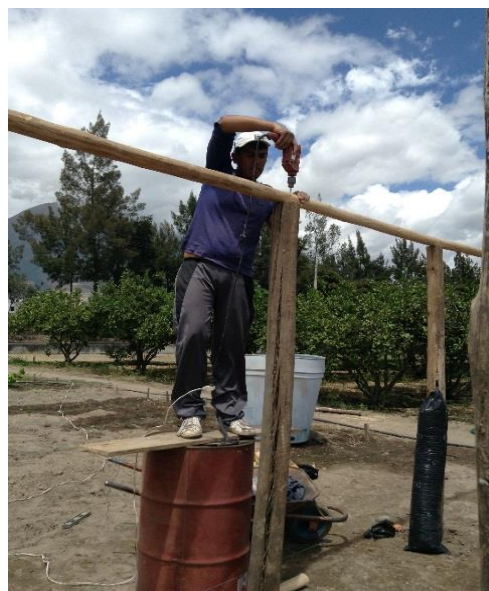
Instalación de estructura hidropónica
