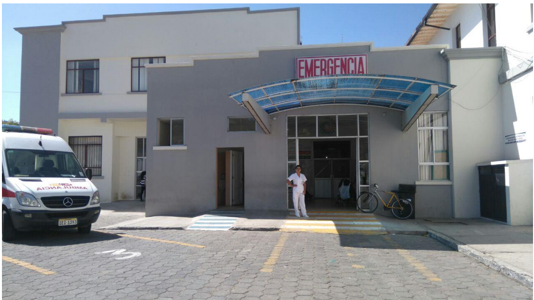
Foto 2: Área de emergencias
