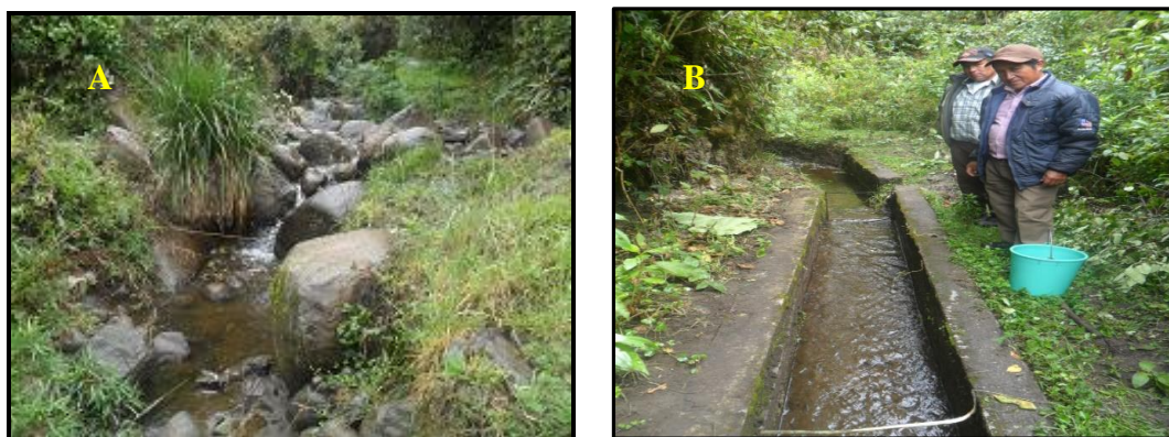
Figura 18. Quebrada Rosauco (A. Fuente de Agua; B. Canal Revestido para agua de riego)
