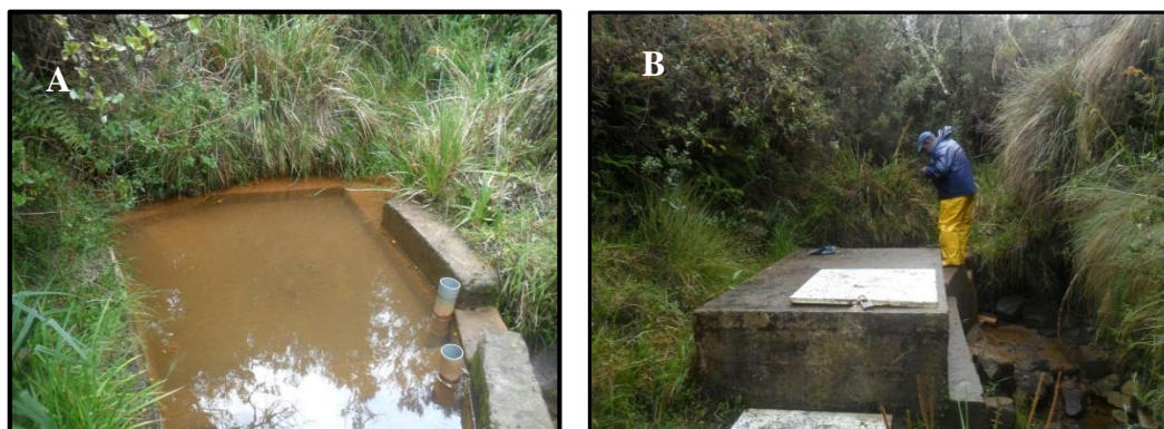
Figura 13. Quebrada la Carbonería 3(A. Fuente de Agua; B. Captación)
