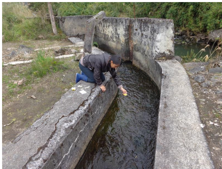
Figuras 4. Medición de caudales con el método del flotador. Fuente: Autora
