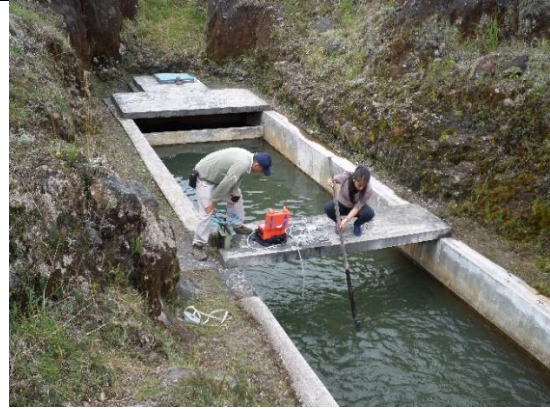
Fotografía 22. Punto aforo 2: Estructura de captación
