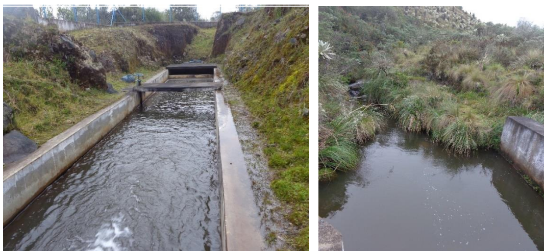
Figura 20. Tanque de captación (i) y sección de la Quebrada Capote, Sector Cucurucho (d). Fuente: Autora
