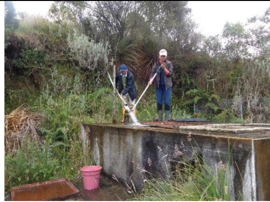
Fotografía 20. Punto aforo 9: Tanque de captación N°2, Sector Los Tablones.
