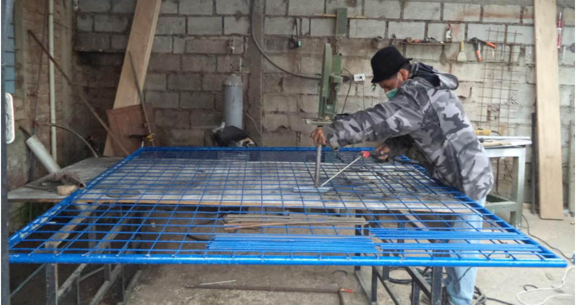
Anexo 22: Proceso de la obra (pintado de la reja)
