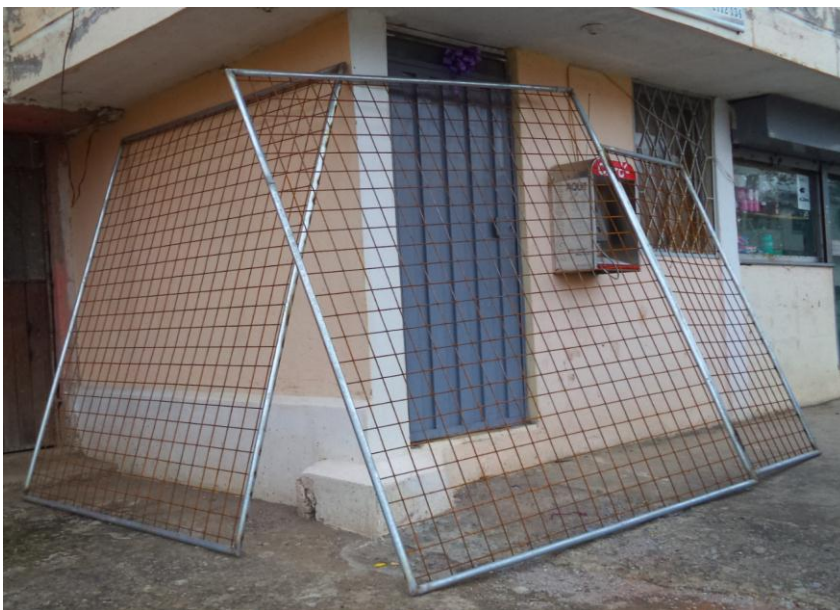
Anexo 21: Proceso de la obra (suelda de la puerta)
