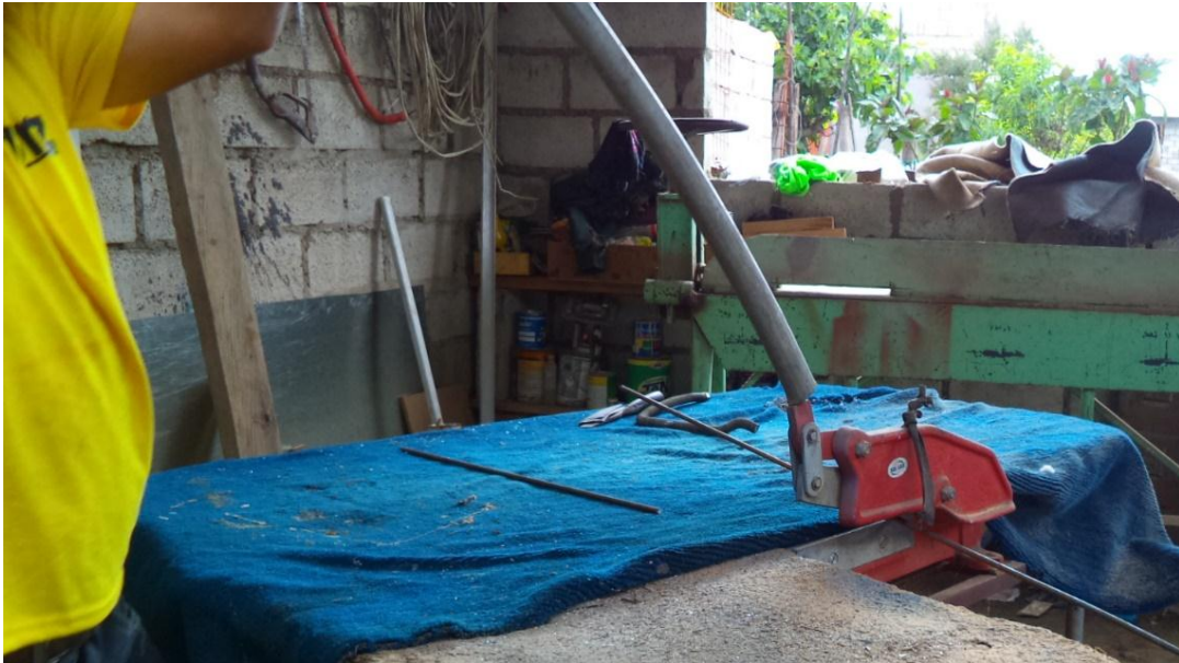
Anexo 17: Proceso de la Obra (corte de hierro para formar las letras)
