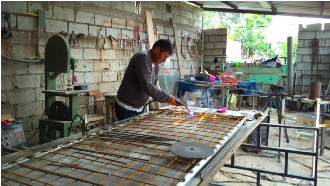
Anexo 20: Proceso de la obra (suelda de las letras)
