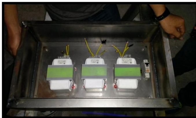
FIGURA 52: Montaje de los transformadores, "Elaboración propia"
