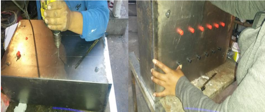
FIGURA 50: Huecos y colocación de Jack banas en el tablero, "Elaboración propia"
