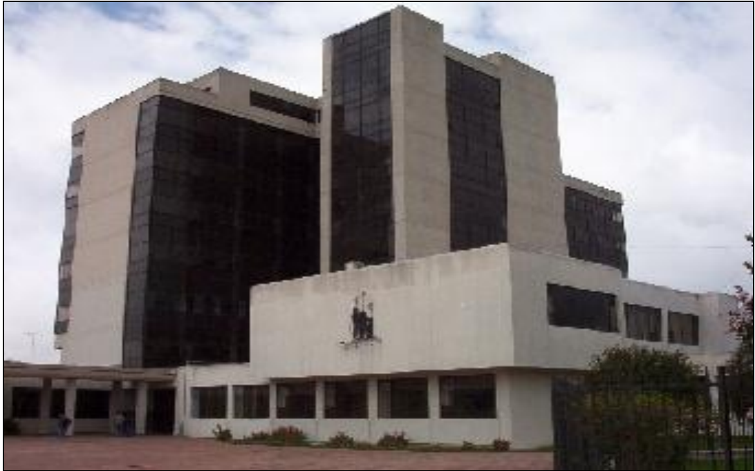
FOTOGRAFIA 1. Exterior del INSTITUTO ECUATORIANO DE SEGURIDAD SOCIAL y del servicio de emergencia
