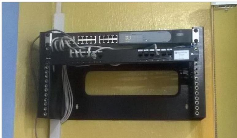
*Figura 4:* Equipos de conexión intermedia sin protección.
