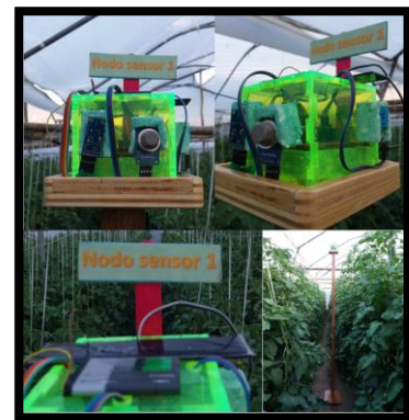
Figura 19. Instalación Nodo Sensor 1
