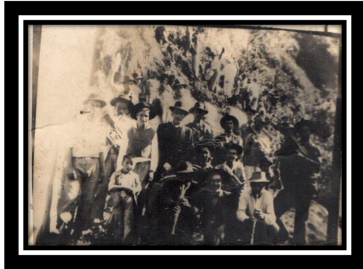
Primera minga de construcción del a carretera
