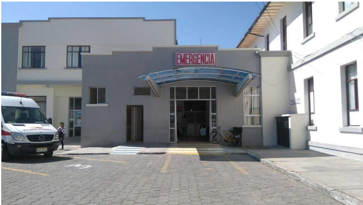
Foto 1: Ingreso – Servicio de Emergencia
