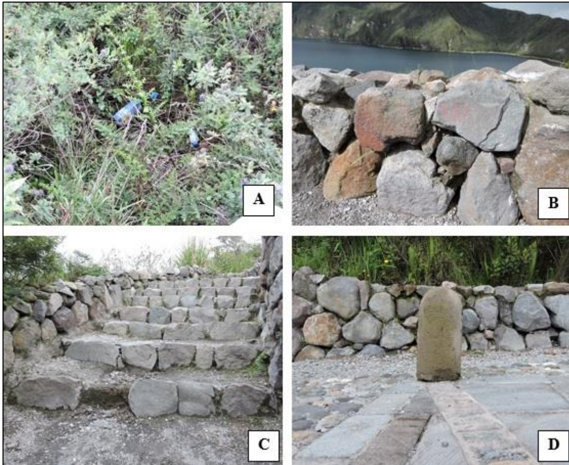
Figura 10. Impactos derivados de la actividad turística: A – Presencia de residuos, B – Grafitis, C – Daños del sendero, D – Daños de la infraestructura
