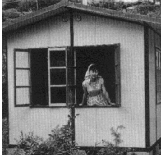
Figura 25.1: Midget House: el origen de la producción en masa de las casas prefabricadas en Japón (Daiwa House Industry Co. Ltd. 2015)
