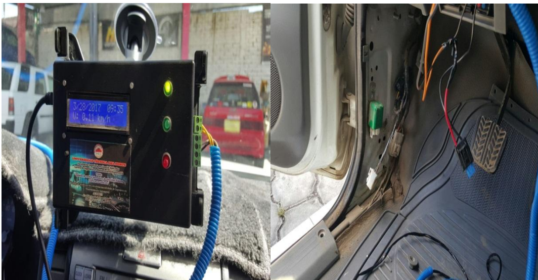
Figura 66 Instalación del GPS en el interior del vehículo Fuente: (Quitama & Túlcan)
