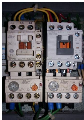
Figura 53. Relay térmico
