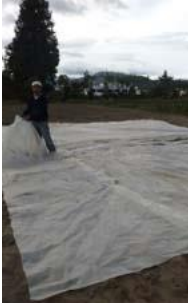
Desinfección del terreno
