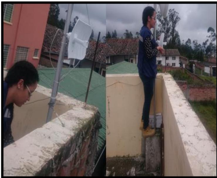
*Figura 60. Montaje y Alineación Litebeam M5-23, La Esperanza.*
