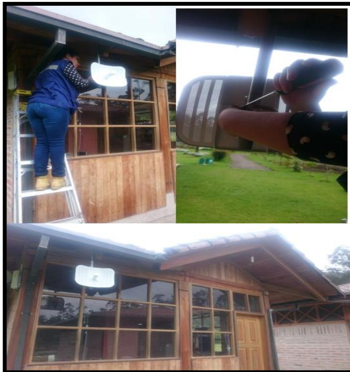
*Figura 59. Colocación y Alineación Litebeam M5-23, Bosque Protector.*
