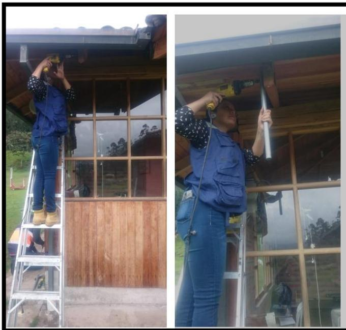
*Figura 57. Implementación Soporte para Antena Litebeam M5-23, Bosque Protector.*
