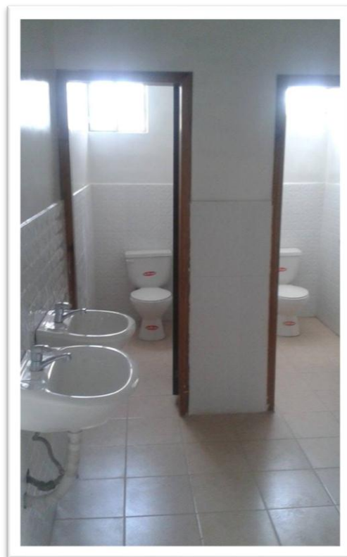
FIGURA 24: Remodelación de lavamanos y sanitarios
