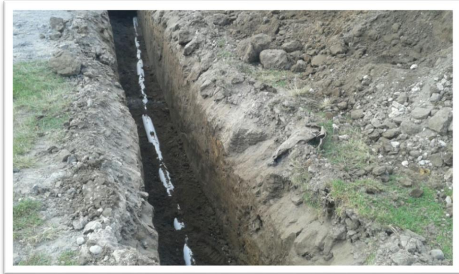
FIGURA 36: Colocación de tubos en el taller para la conexión al alcantarillado de la UTN
