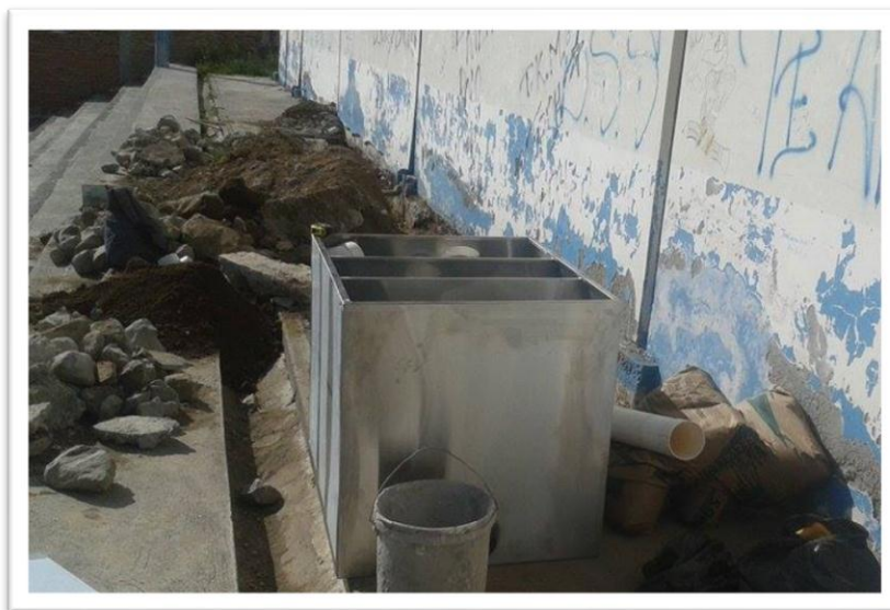
FIGURA 27: Instalación del tanque en el taller ubicado en el colegio Universitario
