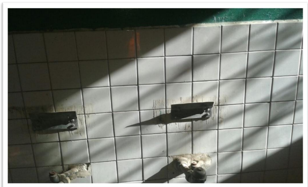
FIGURA 22: Remoción de lavamanos antiguos.
