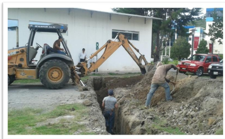
FIGURA 35: Excavación de zanja en la UTN
