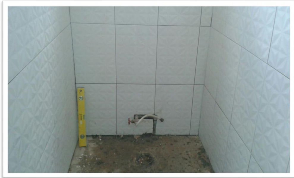
FIGURA 21: Remoción de las baterías sanitarias antiguas.
