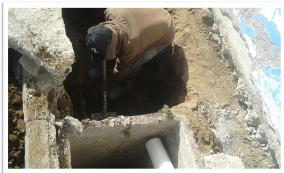
FIGURA 34: Excavación de pozo para instalación de la trampa de grasas del colegio Universitario.
