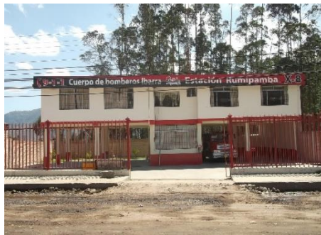
Estación de Bomberos Rumipamba
