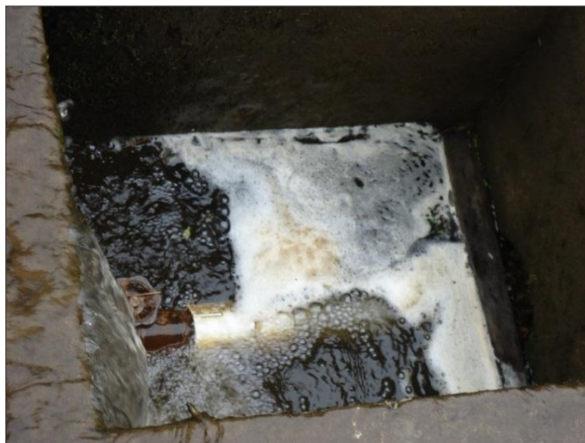
Figura 4.11. Captación de la vertiente Turupamba.
