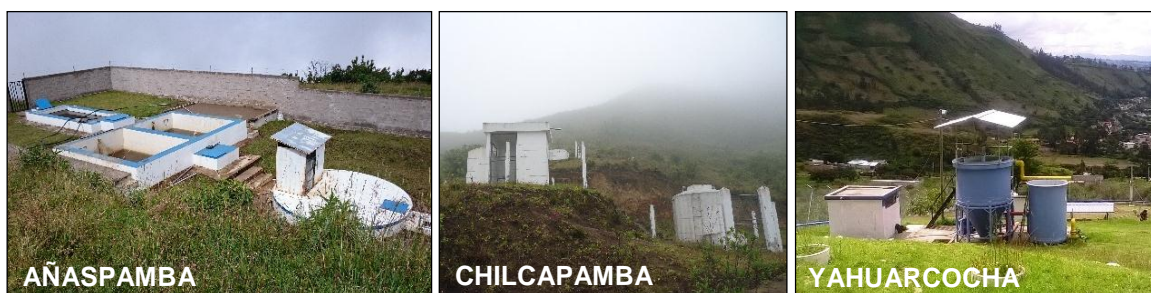
Figura 4.6. Plantas de Tratamiento de Agua Potable de Añaspamba, Chilcapamba y Yahuarcocha
