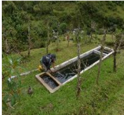
Figura 4.38 Toma de agua Alofitara Elaboración: La Autora
