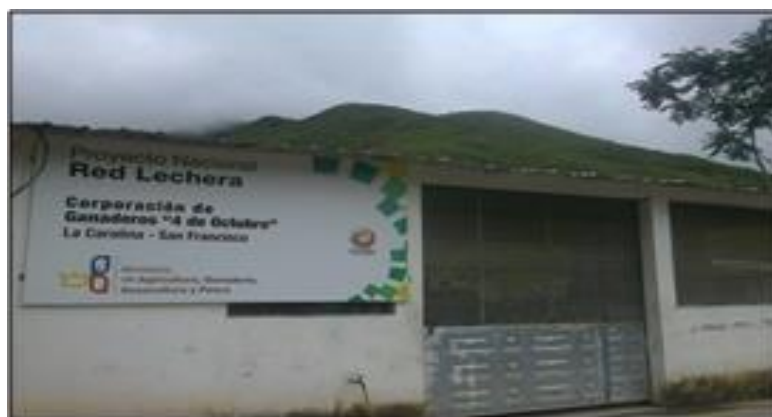
Fotografía 14. Enfriadora ubicada en la comunidad San Francisco
