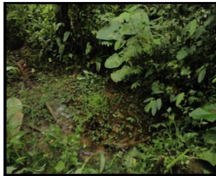
Fotografía 29. La captación recoge el agua de dos vertientes sin protección de la activación ganadera
