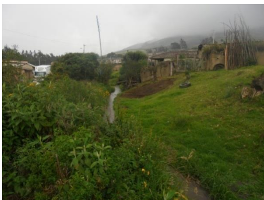
Figura 4 Canal principal del sistema de riego
