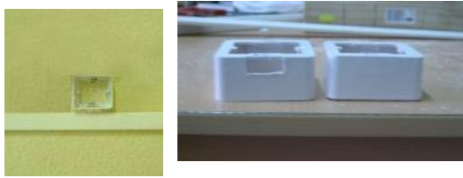
Figura 9. Instalación de faceplates
