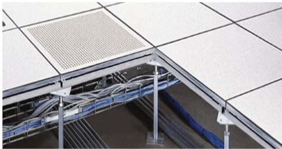
Figura 3: Estructura del Piso Falso Fuente: https://goo.gl/HC20d8
