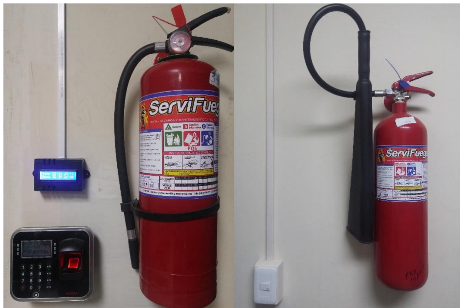
Figura 38. Colocación de ganchos para los extintores. Fuente: Elaborado por el autor
